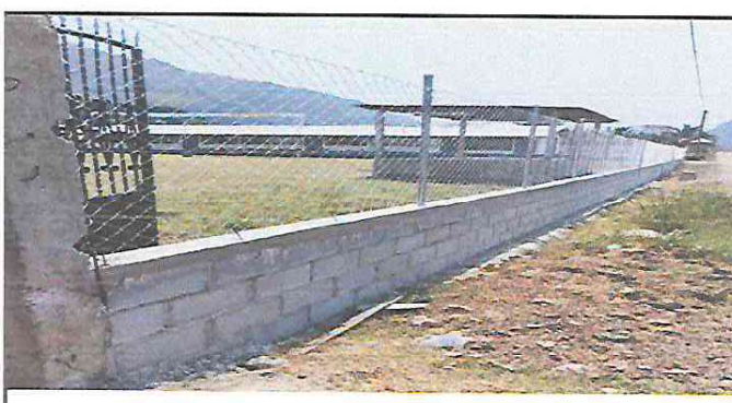
Foto 4: Se observa la finalizacion del Predio de la Escuela.
