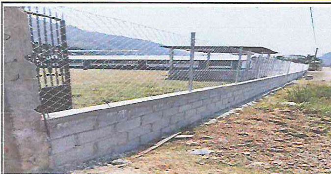
Foto1: Se observa la el trabajo finalizado de la circulacion del predio de la Escuela.
