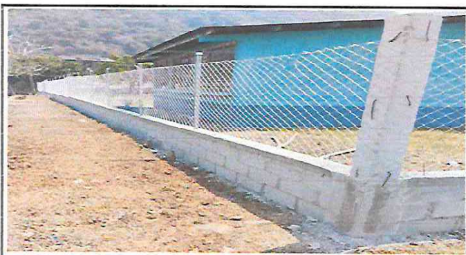
Foto 3: Se observa la finalizacion del Predio de la Escuela
